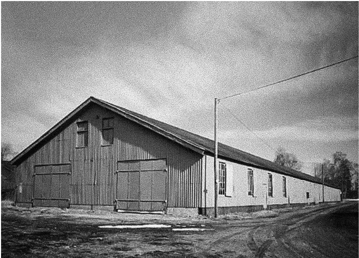
Magasinhallen. Foto: Forsvarsbygg
