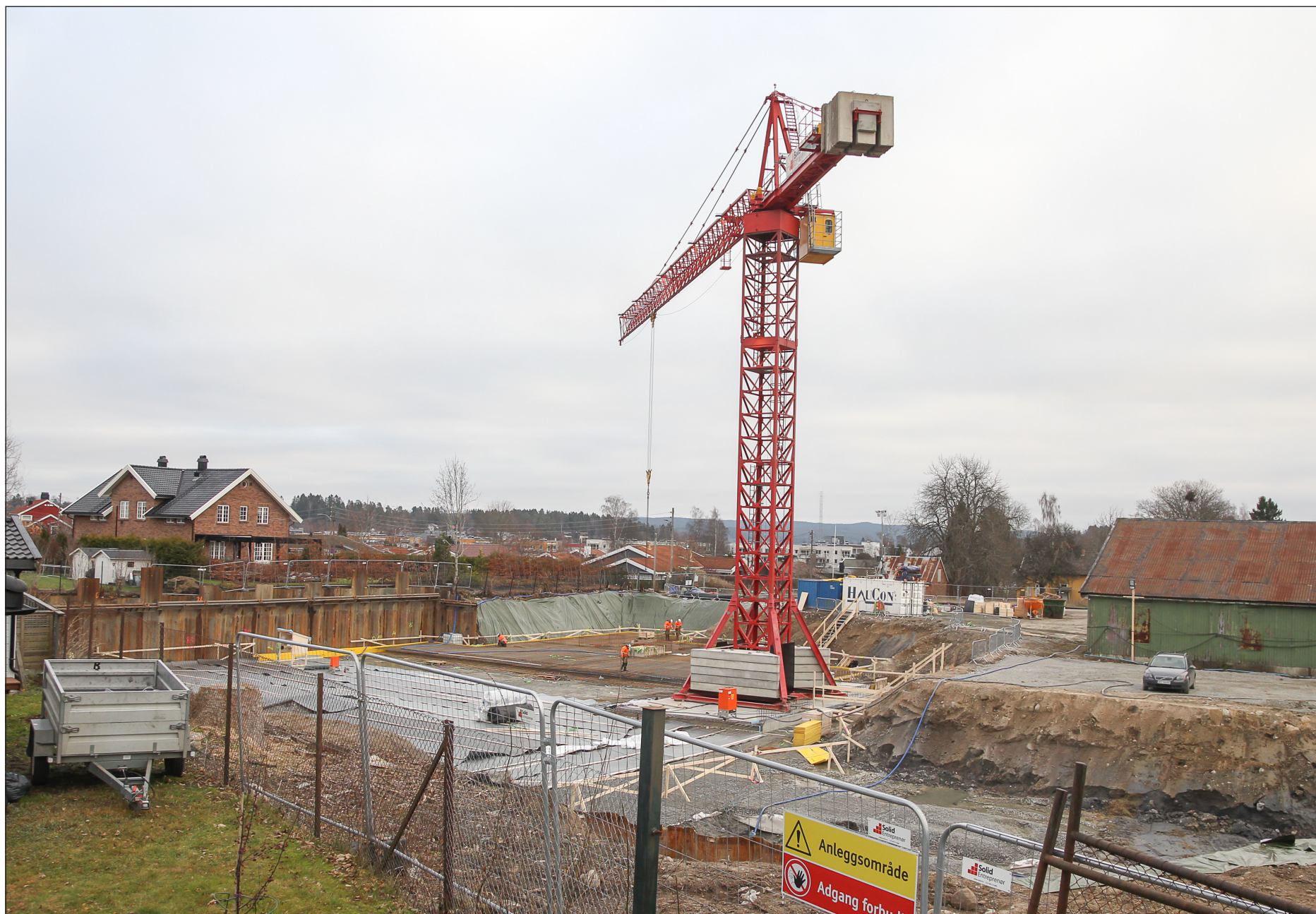
KRAN: Den første heisekranen er på plass i Magasinleiren.
